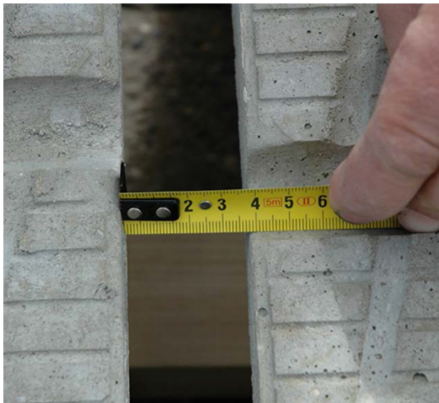
Foto 1: Twee stuks meegeleverde leghulpmiddelen gebruiken om sleufbreedte van 4 cm te garanderen.
