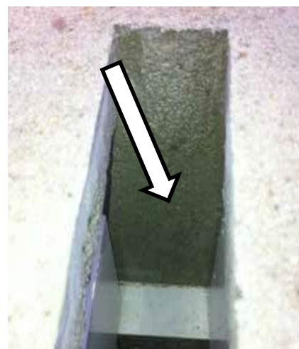
Foto 4: 20 mm Opleg benodigd voor montage klep. Dus na verwijderen specie moet er nog minimaal 20 mm muuroplegging zichtbaar zijn voor de oplegging van de klep.
