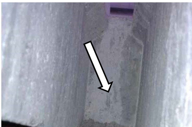
Foto 3: Deze specie ALTIJD verwijderen! Anders is de montage van de emissiereductieklep NIET mogelijk.
